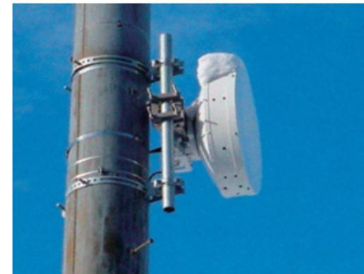
18GHz 帯無線中継回線用パラボラアンテナ
