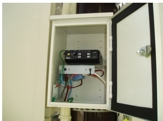
図資 11-11 屋外拡声子局(収納筐体)設置例
