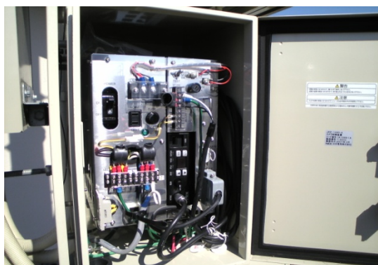
図 資 11-12 屋外拡声子局 (機器ユニット組込)設置例
