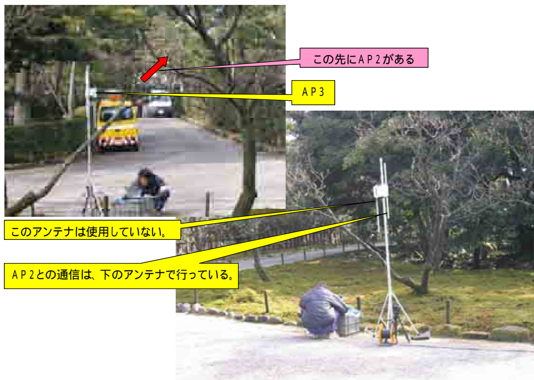
図 4-6 AP3 の仮設状況
