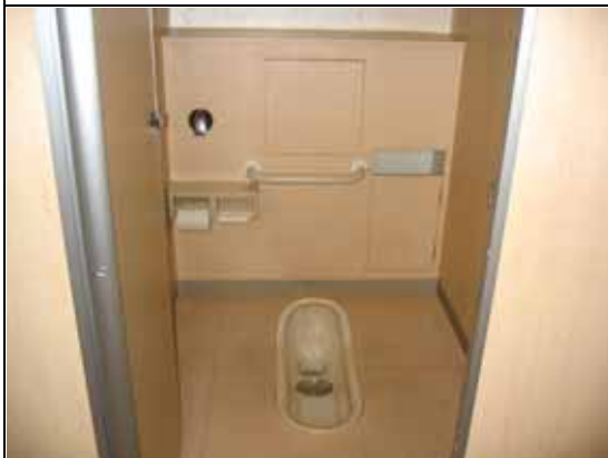
No. 6 : めいてつエムザ 3階 女性 一般トイレ
