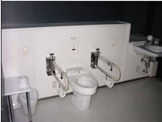
No. 7 : せんだいメディアテーク 2階 男性 多目的トイレ
