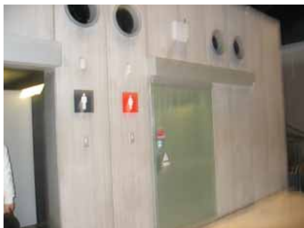
1階トイレ入口
