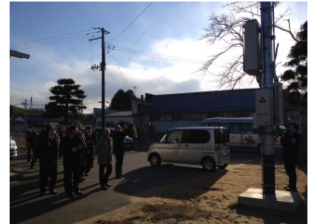
報告会終了後、現地において南相馬チャンネルの 送信設備を視察
