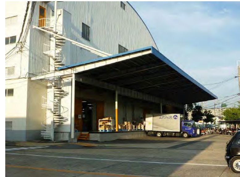
技術試験を実施した倉庫の外観
