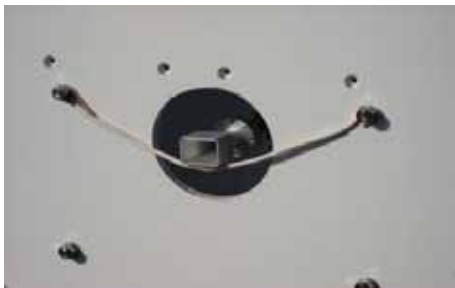
40GHz帯ホーン取り付け状況
