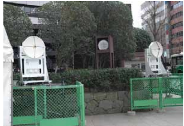
市役所側(子局)アンテナ
