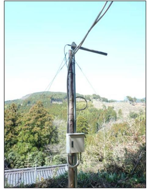
【図 4 - 1 5】 井上清様に建て頂いた木柱を補強し使用、八木アンテナで火の見櫓から送受信
