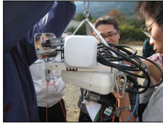
無線 LAN 機材実装
