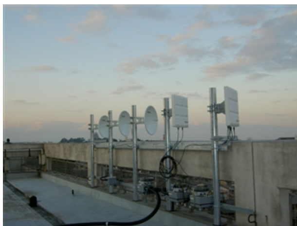
図補-19 2.4/5.0GHz アンテナ設置
