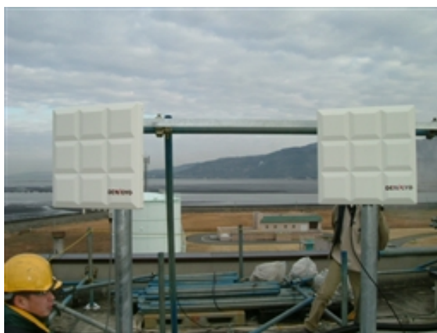
図補-16 2.5GHz アンテナ設置
