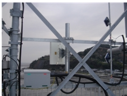
図補-14 25GHz アンテナ設置
