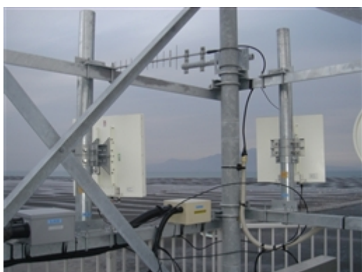
図補-11 2.4GHz アンテナ設置
