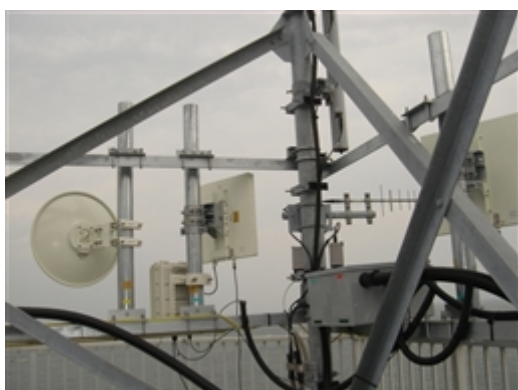
図補-13 2.5GHz アンテナ設置
