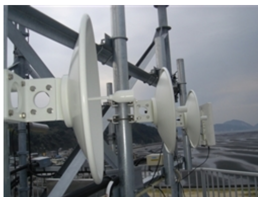
図補-12 5GHz アンテナ設置
