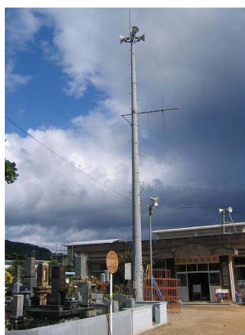
図 2-16 防災用鉄塔との共有イメージ
