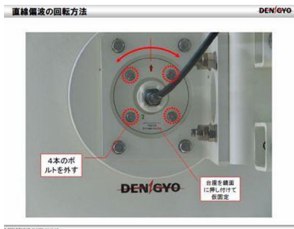
図 3.3.10 アンテナの回転方法（日本電業工作様写真提供）
