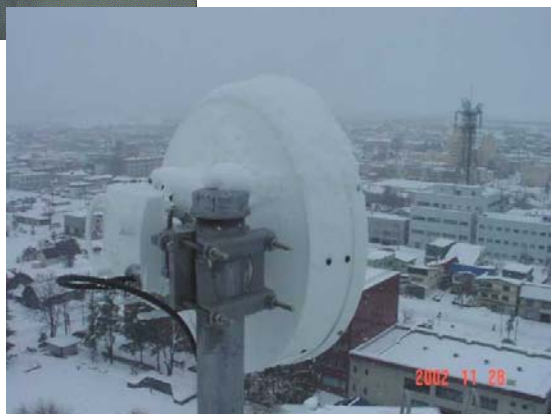
滝川市役所屋上
