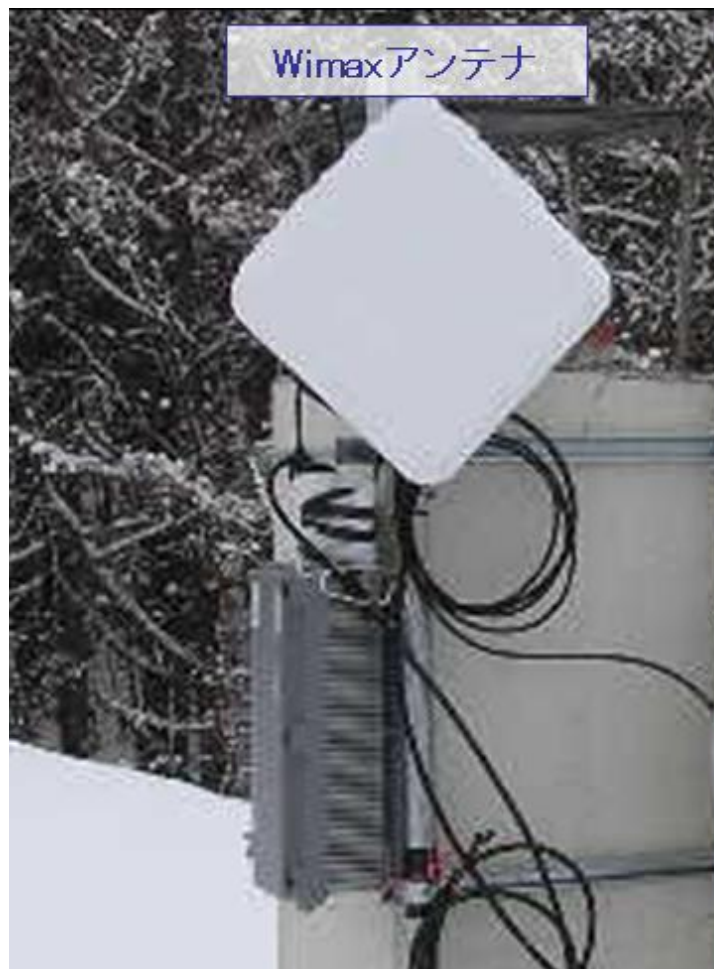
屋外設備(屋上)
