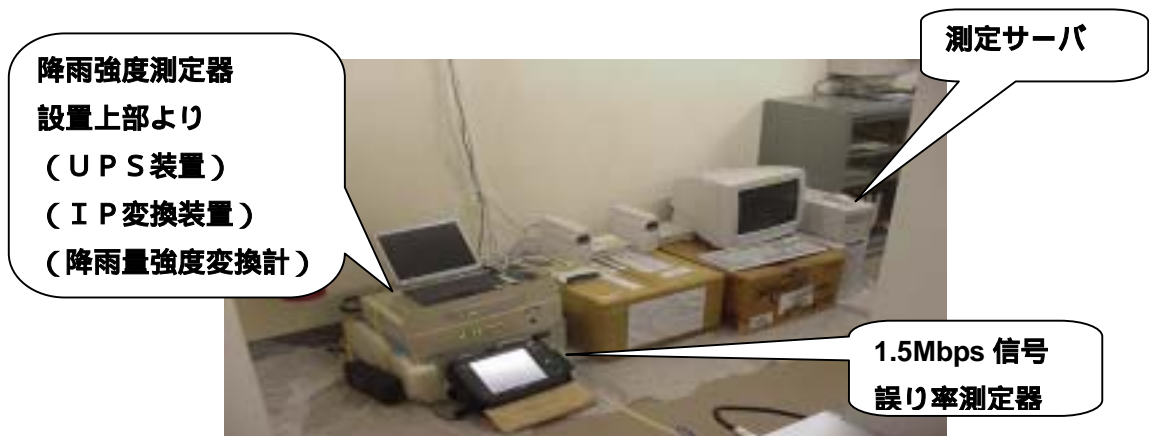
図5 測定機材 設置状況
