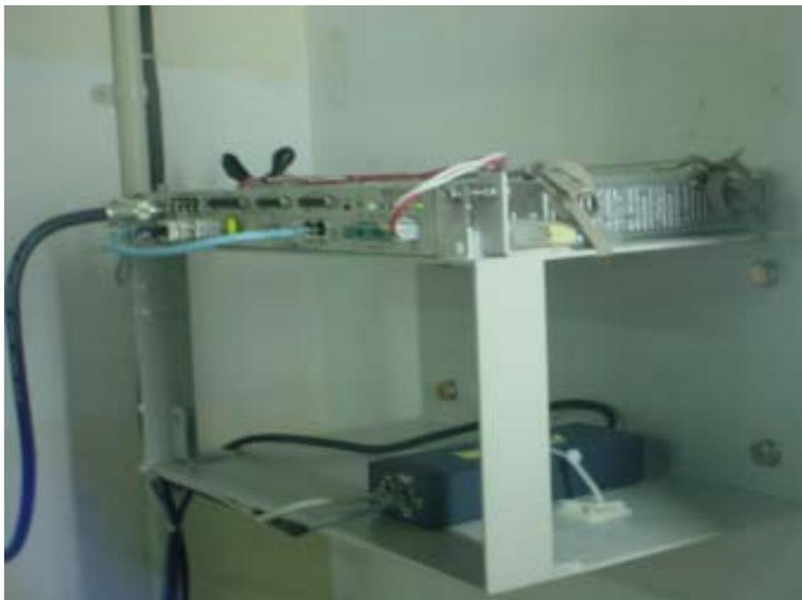
図9.2.9 北大東局 18GHz帯FWA IDU 設置状況
