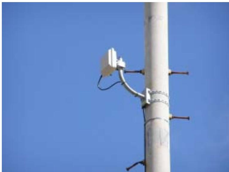
図 9.1.13 セクタアンテナ(指向性：30度)
