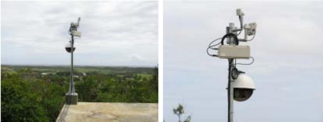
図9.2.11 5GHz帯FWA設置状況（貯水槽／基地局）
