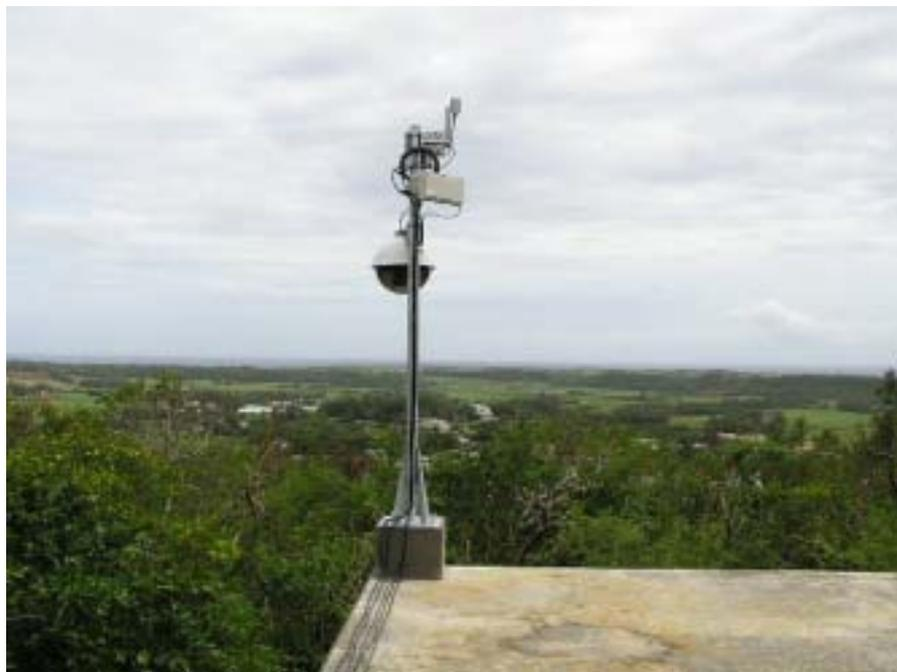
図9.1.12 貯水槽 中継用基地局 設置状況
