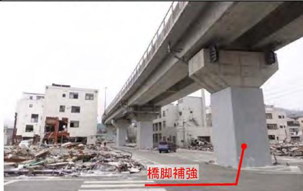
**【耐震補強済み(鋼板巻立補強)】**
