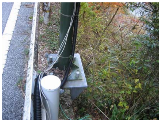
図 17 表示機ポール基礎の例
