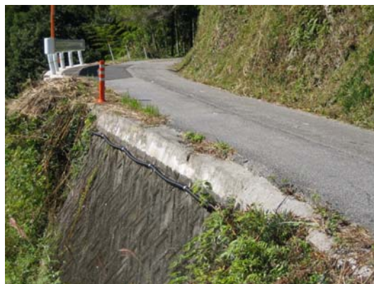
図 18 露出ケーブルの例（白木谷）
