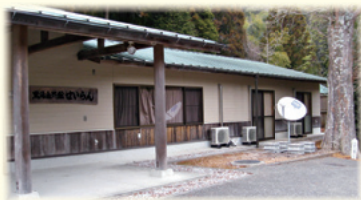
研修宿泊所（指定避難所）の設置状況
