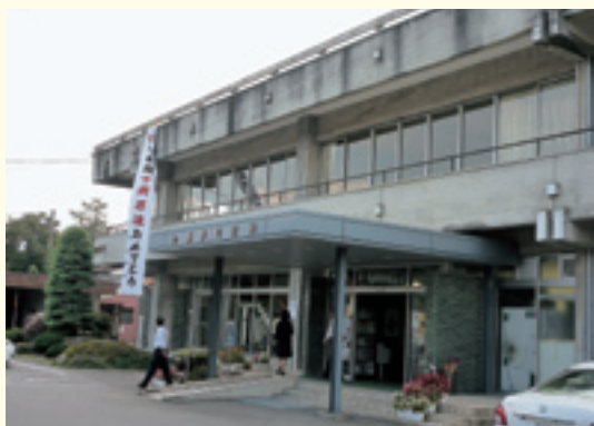
埼玉県小鹿野町役場
