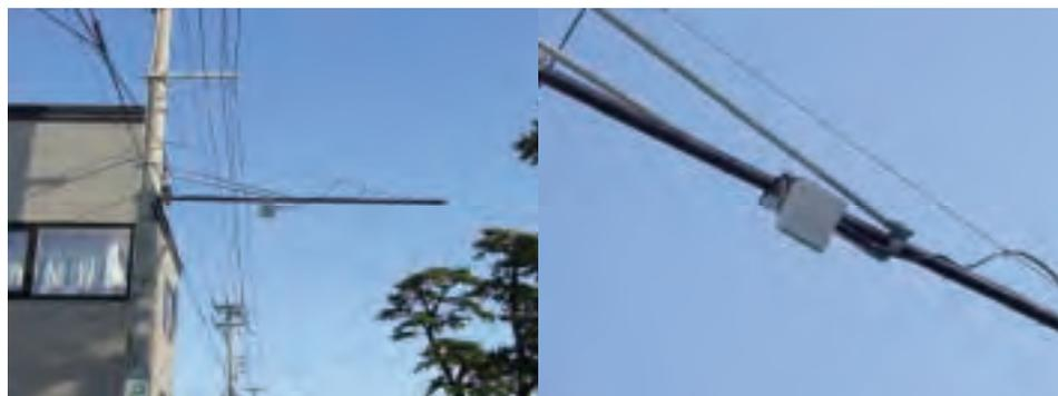
写真 4-2-8 DSRC 無線部設置状況（高さ 4 m にアームで取り付け）
