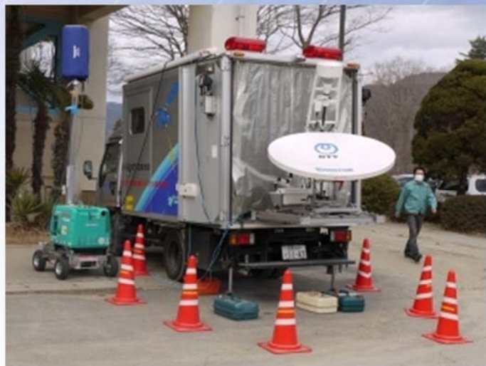
▲通信事業者による衛星通信回線の確保(女川町)
