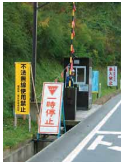
公共工事現場入口へ看板設置
