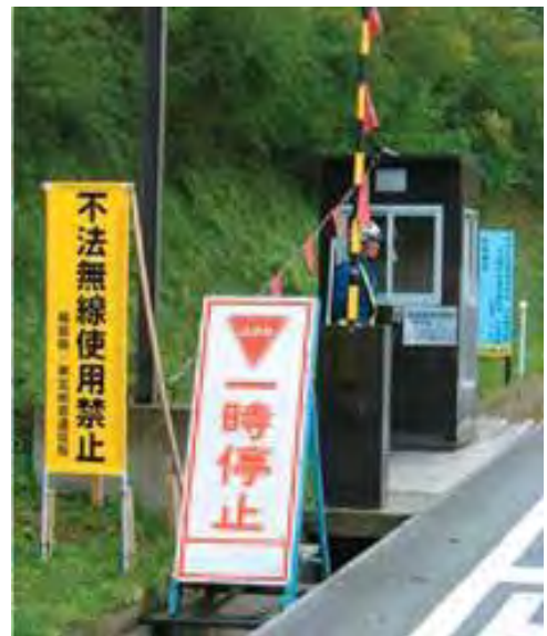
公共工事現場入口へ看板設置
