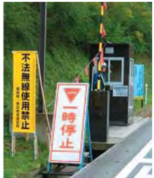
公共工事現場入口へ看板設置
