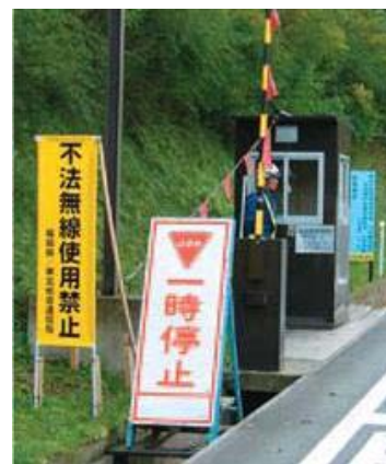
公共工事現場入口へ看板設置
