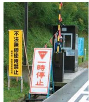
公共工事現場入口へ看板設置
