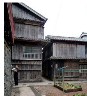
改修対象となる空き古民家
