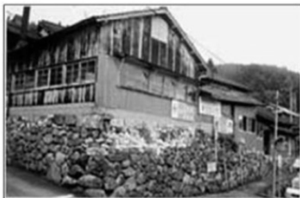
波佐見町 改修前の窯元・工場跡 みんなで改修
