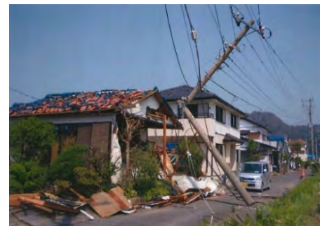
令和元年房総半島台風による被害の状況 (鋸南町提供)
