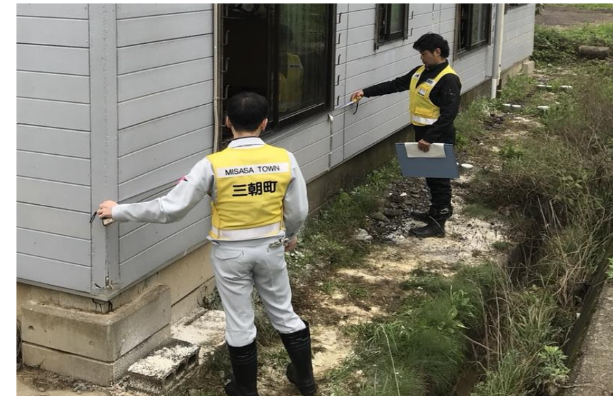
建物被害認定調査 (長野県飯山市)
