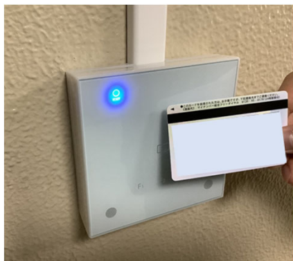
本庁舎での活用 (各フロアに設置されたカードリーダーで認証) (愛媛県新居浜市)
