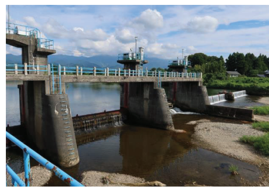
主水源の取水施設である坂井川頭首工
